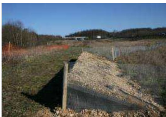
Exemple de barrière à amphibiens avec échappatoire
