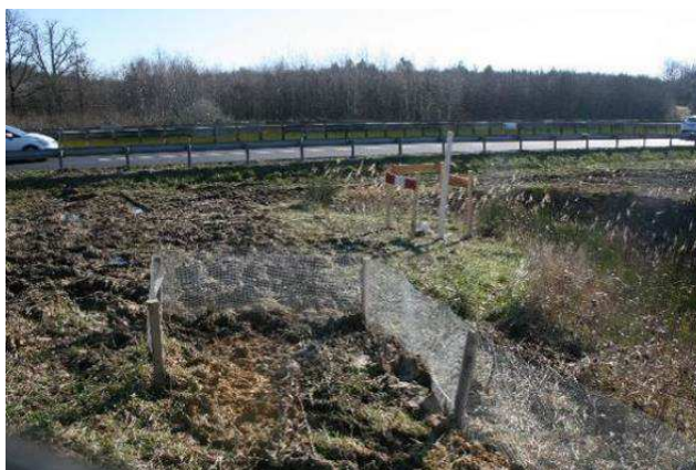
Exemple de retour en U à l'extrémité d'une clôture à amphibiens
