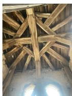
Cette charpente, entièrement en chêne, en forme de carène de vaisseau renversée, date du XVI<sup>ème</sup> siècle ; pourtant, elle semble quasiment intacte. Il se dégageait une émotion palpable au vu de l'œuvre des compagnons bâtisseurs d'il y a six siècles qui a traversé les temps en si bon état de conservation. L'an prochain, l'expérience sera sûrement renouvelée, alors n'hésitez pas et venez découvrir ce trésor caché.
